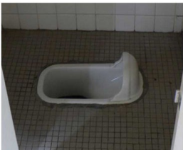
○ トイレの整備
